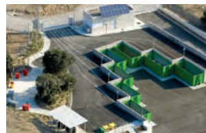
Vista aérea del Punto Limpio de Villanueva del Pardillo.
