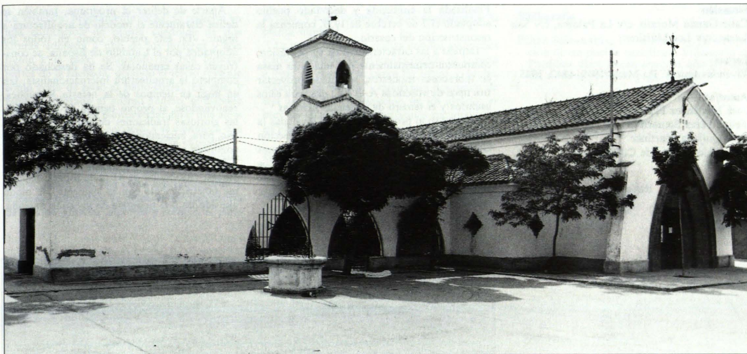
Vista de conjunto. Estado actual.
